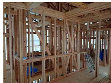
〔「あきた材パートナー」 が建設した住宅内部〕
