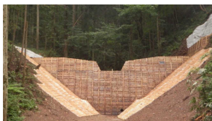
〔木製残存型枠〕
