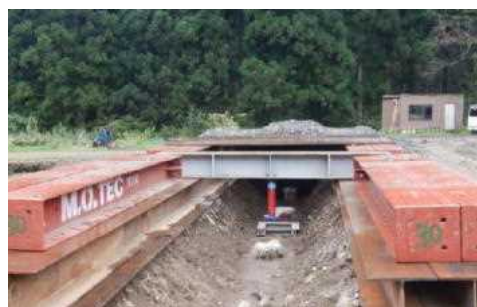
〔スギ丸太杭載荷試験の状況〕
