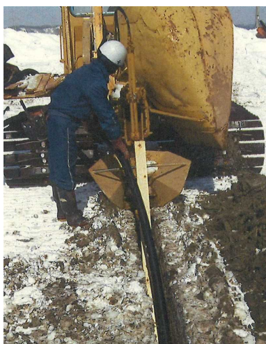
〔暗渠工の施工状況〕
