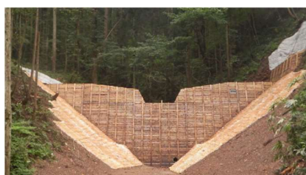
〔木製残存型枠〕
