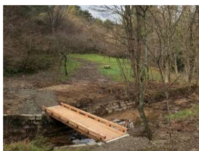
〔遊歩道内に歩道橋として整備〕
