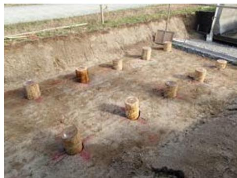
〔木杭基礎工法の試験施工の様子〕
