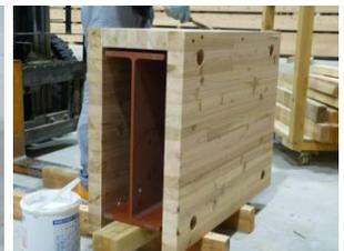
〔柱となる角型鋼管をスギ集成材で被覆〕
