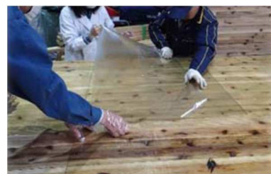
【FRP シートによる被覆処理】
