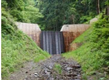
【木製残存型枠工】
