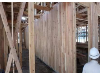
【C L T耐力壁の建て込み】
