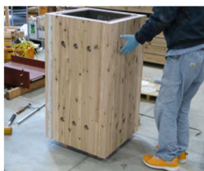
【柱となる角型鋼管にスギ集成材で被覆】
