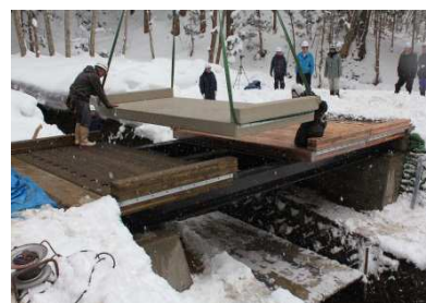
【CLT床板施工状況】
