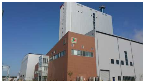
【木質バイオマス発電施設】
