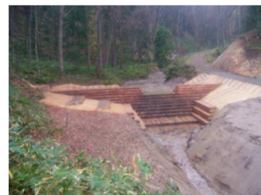
【木製治山ダム】
