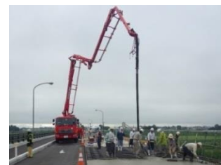
橋梁修繕工事
