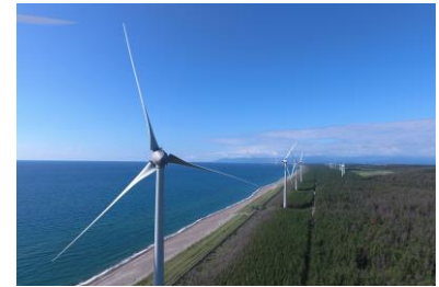
風の松原風力発電所：能代市
