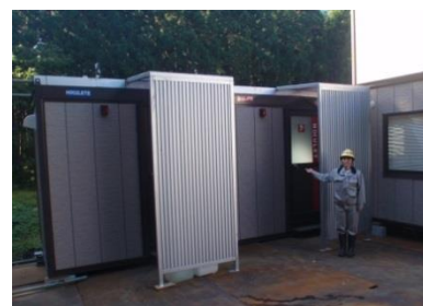
現場に設置した快適トイレ
