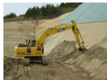
I C T建設機械による土工
