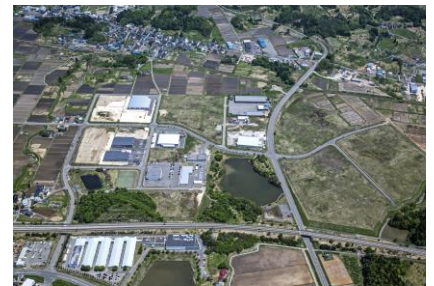
横手第二工業団地
