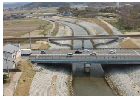
河川改修状況（新城川・秋田市）
