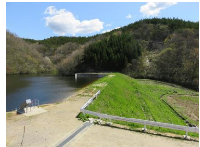
老朽化ため池の改修
