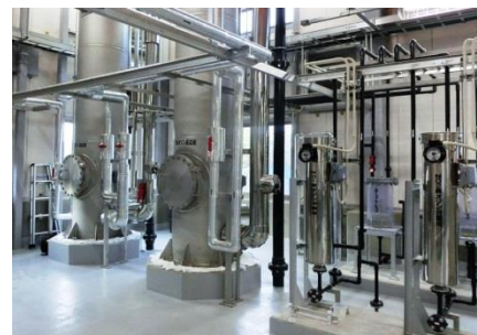
能代産業廃棄物処理センターの 高度な水処理施設（促進酸化施設）
