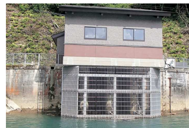
第二田沢取水口(施工後)
