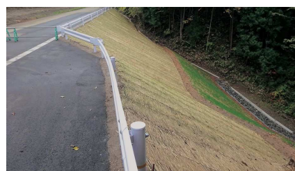
地すべり防止施設の完成状況 （鹿角市 堪忍沢）
