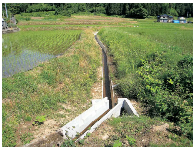
横手市三又南地区（用排水路工）
