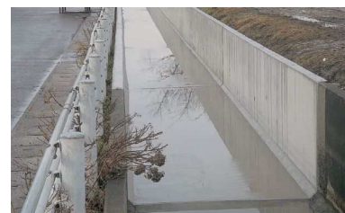
旭川左岸幹線用水路(施工後)
