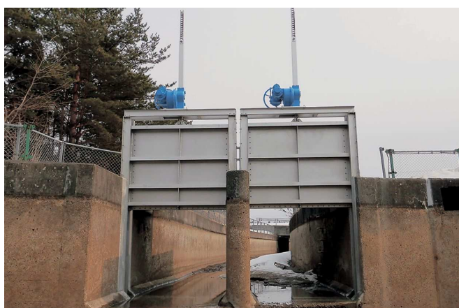
ゲートの更新 能代1期地区（能代市）
