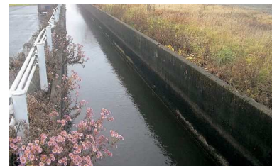
旭川左岸幹線用水路(施工前)
