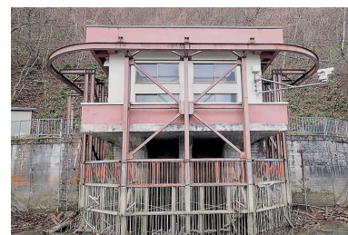
第二田沢取水口(施工前)
