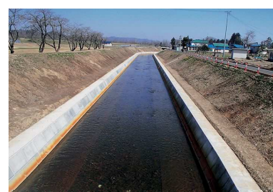
大宮川幹線排水路
