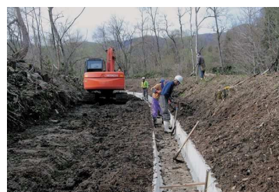
水路の更新 濁川地域資源保全活動組織（小坂町）
