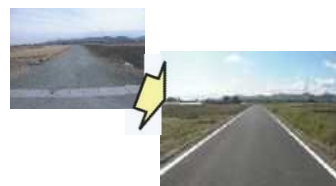
農作業道の整備
