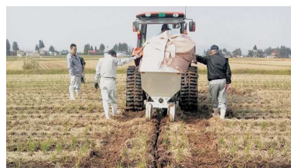
モミガラ補助暗渠の施工状況 （美郷町）
