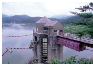
皆瀬ダム取水塔全景
