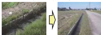
老朽化した水路の整備
