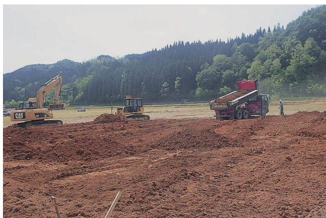
客土整備 鹿角第二地区（鹿角市）
