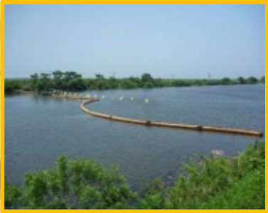
アオコ遡上防止フェンス 馬場目川 (H29. 7. 14)
