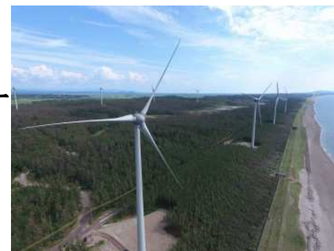
風の松原風力発電所(能代市)
