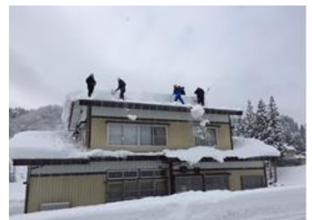
共助組織による雪下ろし作業
