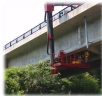
橋梁点検作業
