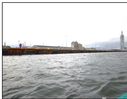
写 2-1-(2) 係留施設の例
