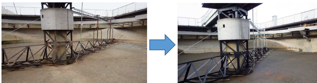
写真 3-VIII 具体事例【秋田臨海処理センター 最初沈殿池 汚泥かき寄せ機 更新】
