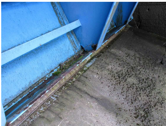
写 3-4-(1) 機械設備損傷例
