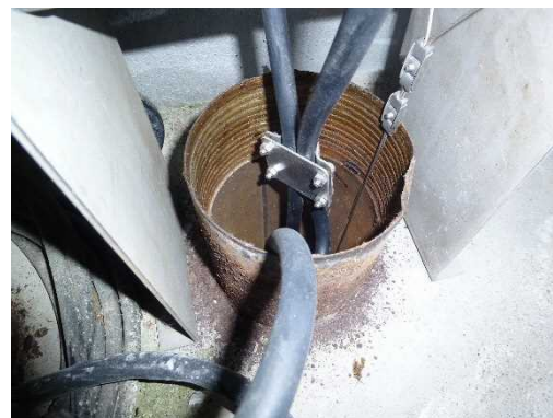
写 3-6-(1) 電気通信設備損傷例
