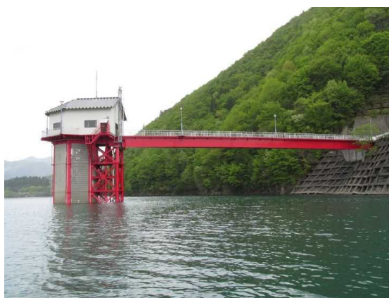
写 2-1-(2) 機械設備の例
