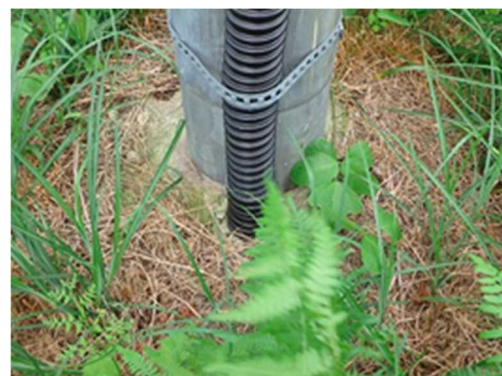
写 3-6-(1) 電気通信設備損傷例
