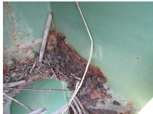
写 3-4-(1) 機械設備損傷例
