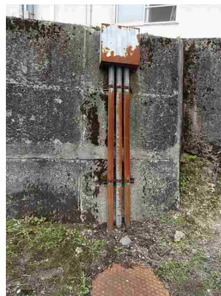
写 3-6-(1) 電気通信設備損傷例
