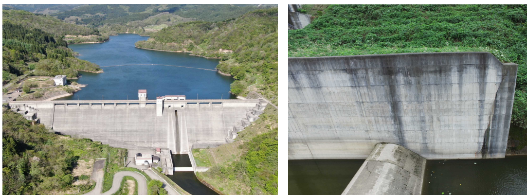
写 2-1-(1) 土木施設の例
