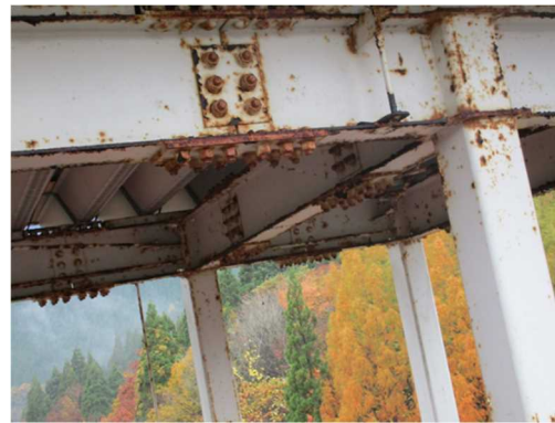
写 3-4-(1) 機械設備損傷例
