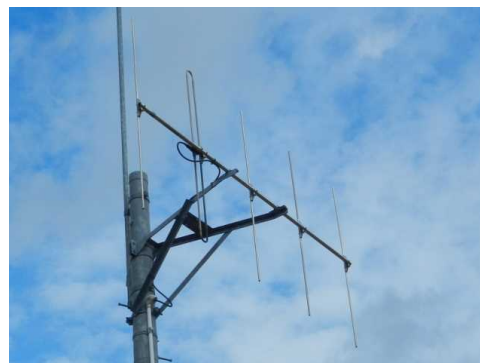
写 3-6-(1) 電気通信設備損傷例
