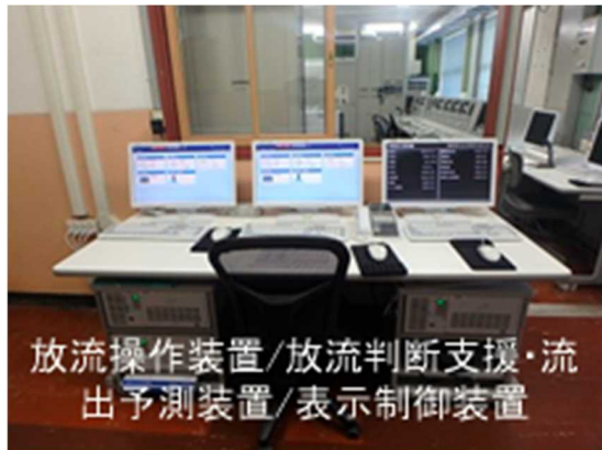
写 2-1-(3) 電気通信設備の例
