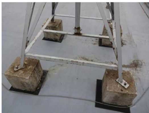
写 3-6-(1) 電気通信設備損傷例
