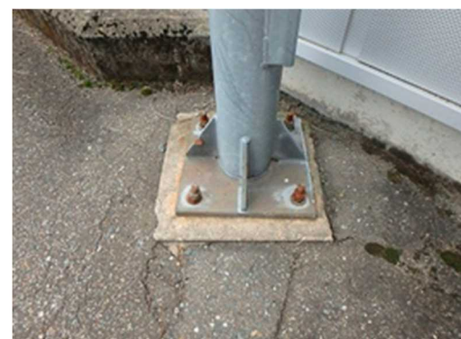
写 3-6-(2) 電気通信設備損傷例
