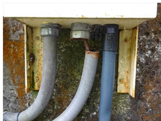
写 3-6-(2) 電気通信設備損傷例
