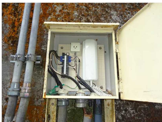
写 3-6-(2) 電気通信設備損傷例
