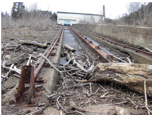
写 3-4-(2) 機械設備損傷例
