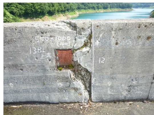
写 3-2- (1) 土木施設損傷例
