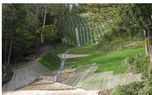
土留工 法枠工
