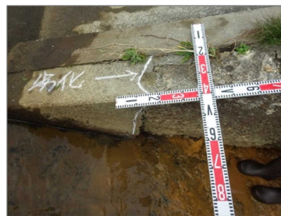
（写 3-2 翼壁・川表損傷例）
