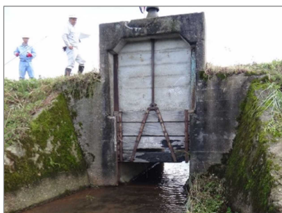
（写 3-2 ゲート損傷例）
