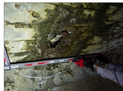
（写 3-2 函体・頂版損傷例）
