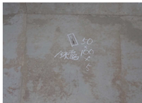
左側函体 側壁 鉄筋露出
