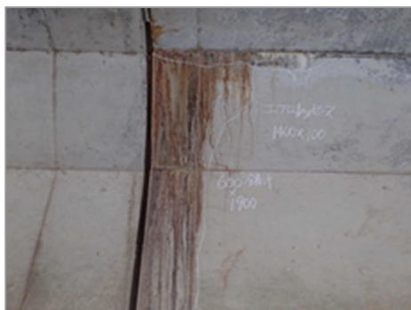
左側函体 頂版 錆汁
