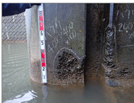
右側函体 側壁 剥離・欠損状況
