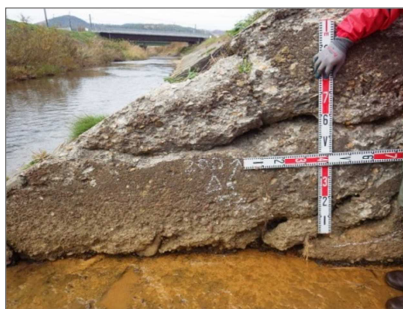
（写 3-2 翼壁・川表損傷例）
