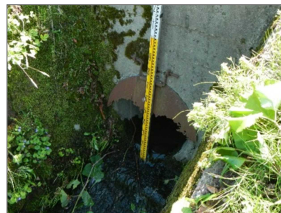
（写 3-2 ゲート損傷例）
