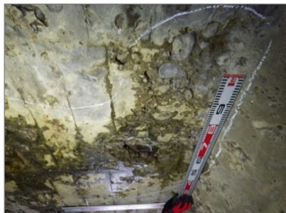
（写 3-2 函体・頂版損傷例）
