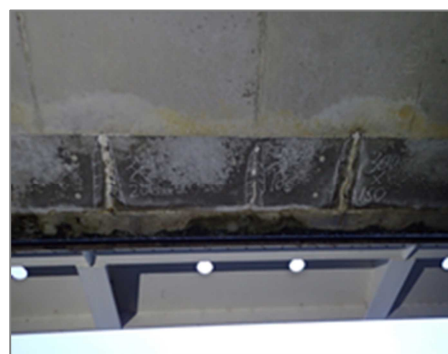
右側函体 頂版 エフロレンス
