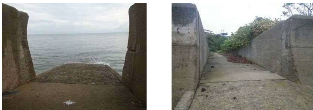
写真－ 1.5 八斗崎第1曳船道 現況写真 (平成28年9月撮影)
