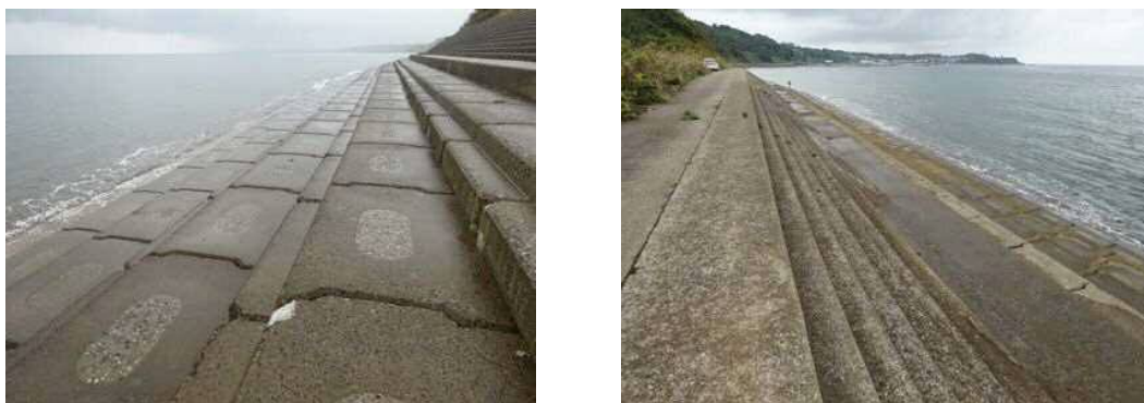
写真－ 1.3 ⑧、⑩相川護岸 現況写真 (平成28年9月撮影)
