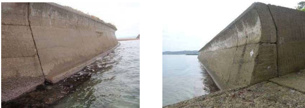
写真－ 1.1 ①八斗崎護岸 現況写真 (平成28年9月撮影)
