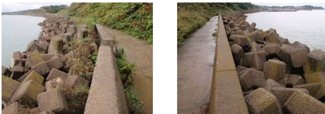
写真一 1.2 ④～⑦、⑪相川護岸 現況写真 (平成 28 年 9 月撮影)
