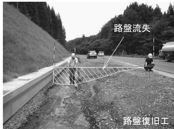
国道105号 草峠工区 (仙北市)
