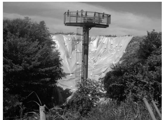
写真2 応急対応状況
