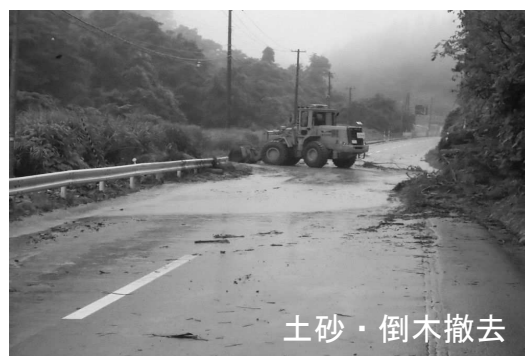
応急復旧状況
