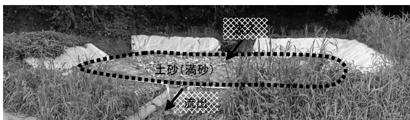
土砂溜現況写真(土砂堆積状況: 深さ約 1.5m)
