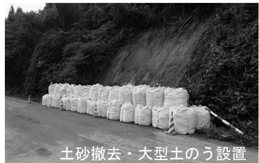
応急復旧状況
