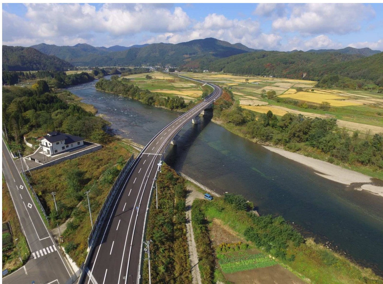
国道103号 葛原バイパスと葛原新大橋（H28. 10全線開通）
