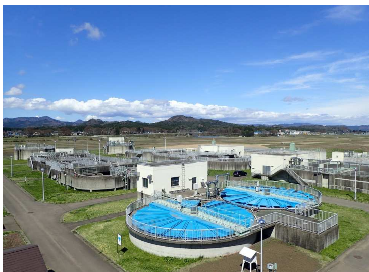
1系水処理施設（最終沈殿池）更新工事
