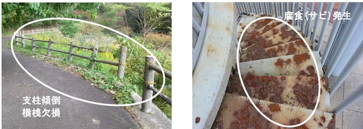
転落防止柵の取替 [小泉湯公園]
