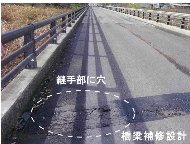
国道398号 久保橋（湯沢市）
