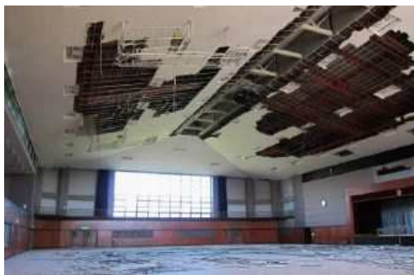
体育館：天井脱落、下地破損
