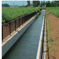
農業土木 水の供給
