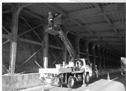
道路施設点検
