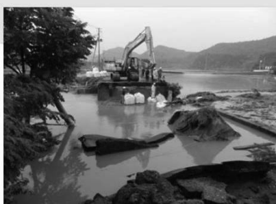
災害復旧作業
