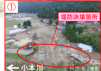
堤防決壊状況
