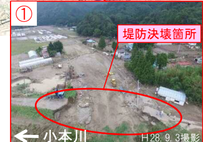
堤防決壊状況
