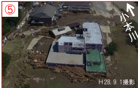
流木堆積状況
