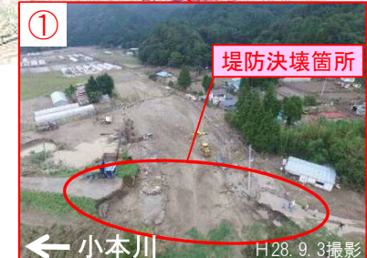
堤防決壊状況
