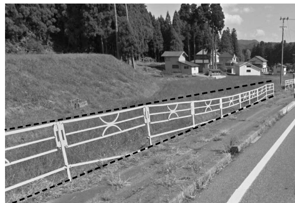
国道105号 南外及位工区(大仙市)
