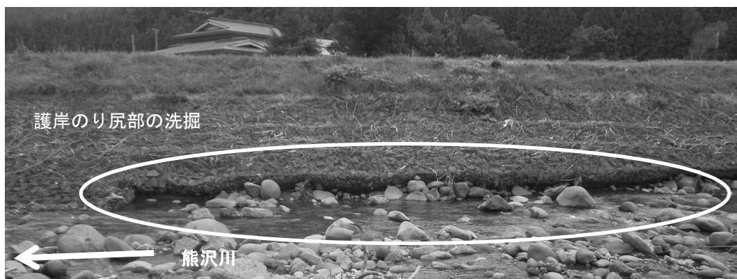
熊沢川（鹿角市） 護岸工・根固工
