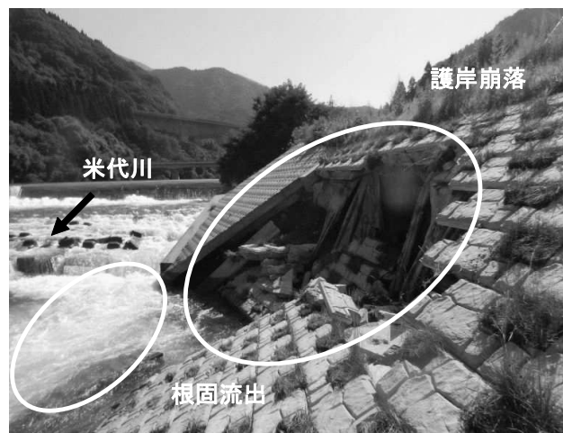
米代川（鹿角市） 護岸工・根固工
