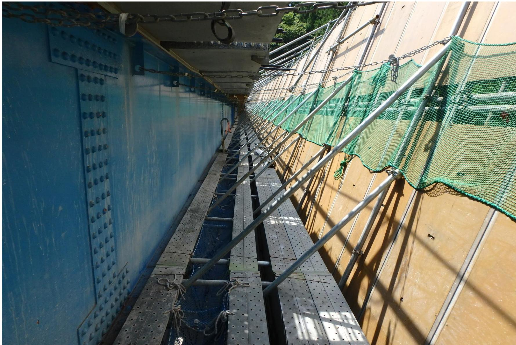
吊り足場の設置状況 支承取替え 橋台部でのジャッキアップ
