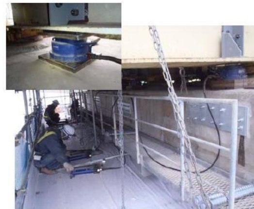
解説 写 8.2.8 沓座部でのジャッキアップ 沓座補強あり
