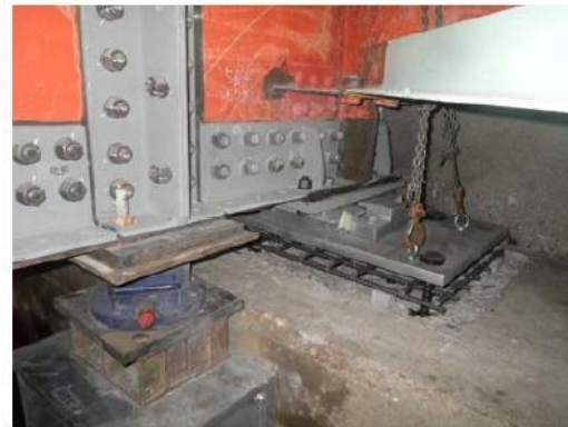
解説 写 8.2.7 下部工ブラケットによるジャッキアップ
