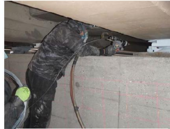
解説 写 8.2.6 金属溶射施工状況(コンクリート橋)
