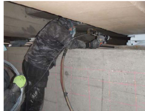
解説 写 8.2.6 金属溶射施工状況(コンクリート橋)
