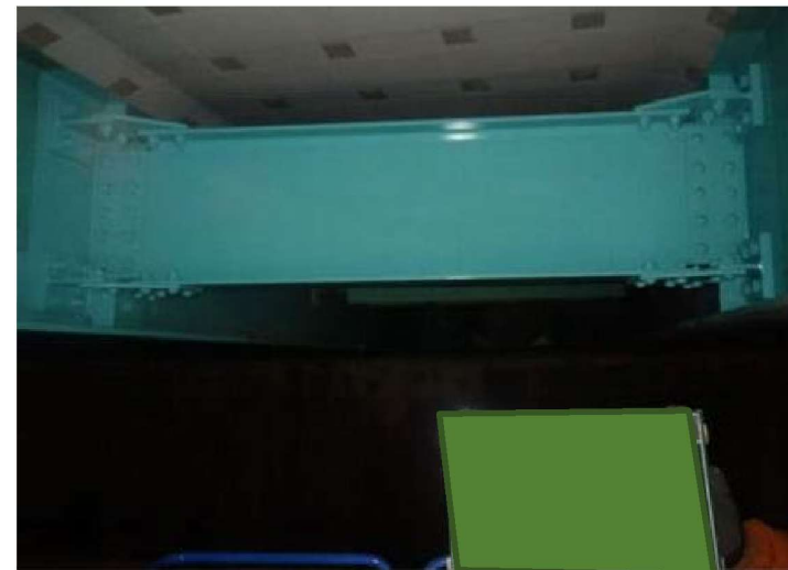
横桁交換（構造ディテールの改善）
