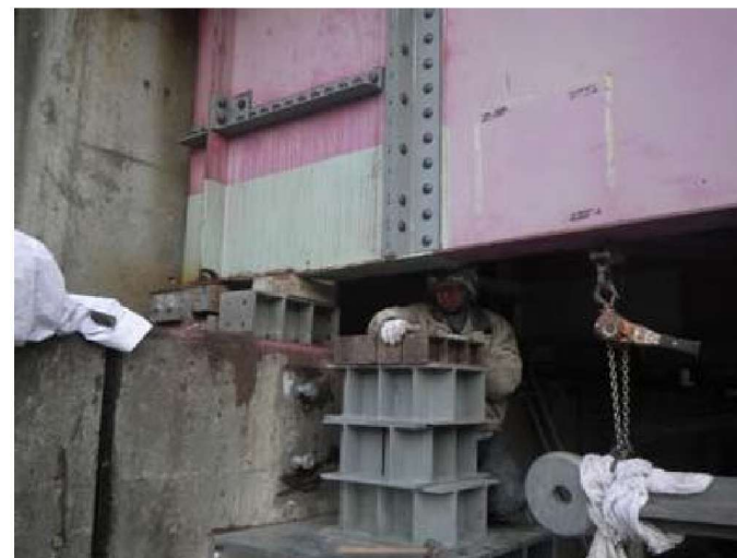
補強材の設置状況
