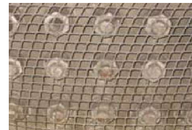
落下防止ネットの取付
