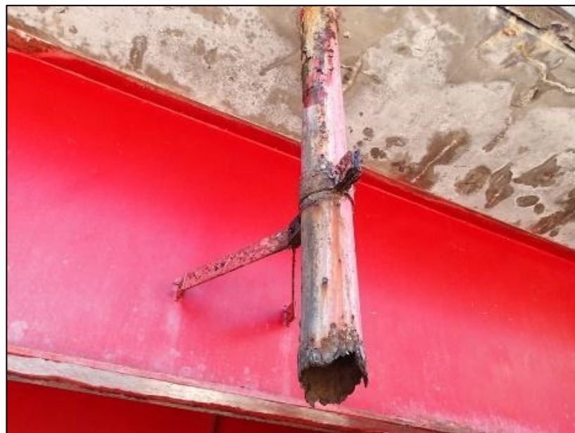
排水管の腐食
