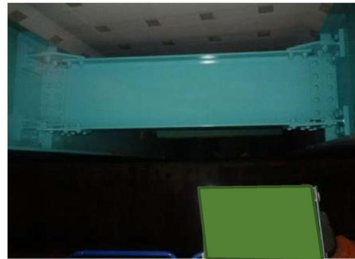
横桁交換（構造ディテールの改善）
