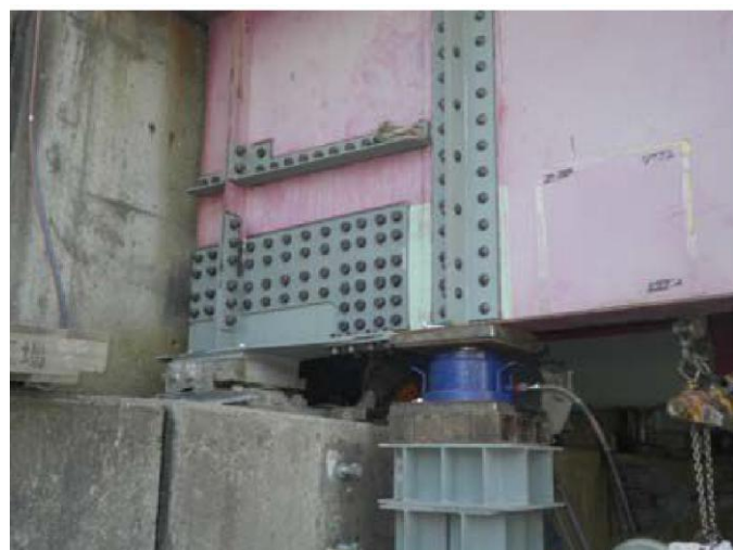
部材交換実施後
