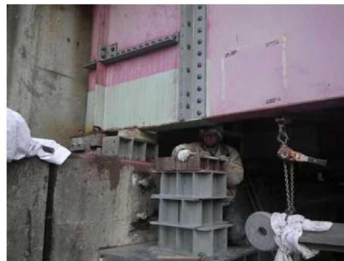
補強材の設置状況
