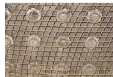
落下防止ネットの取付
