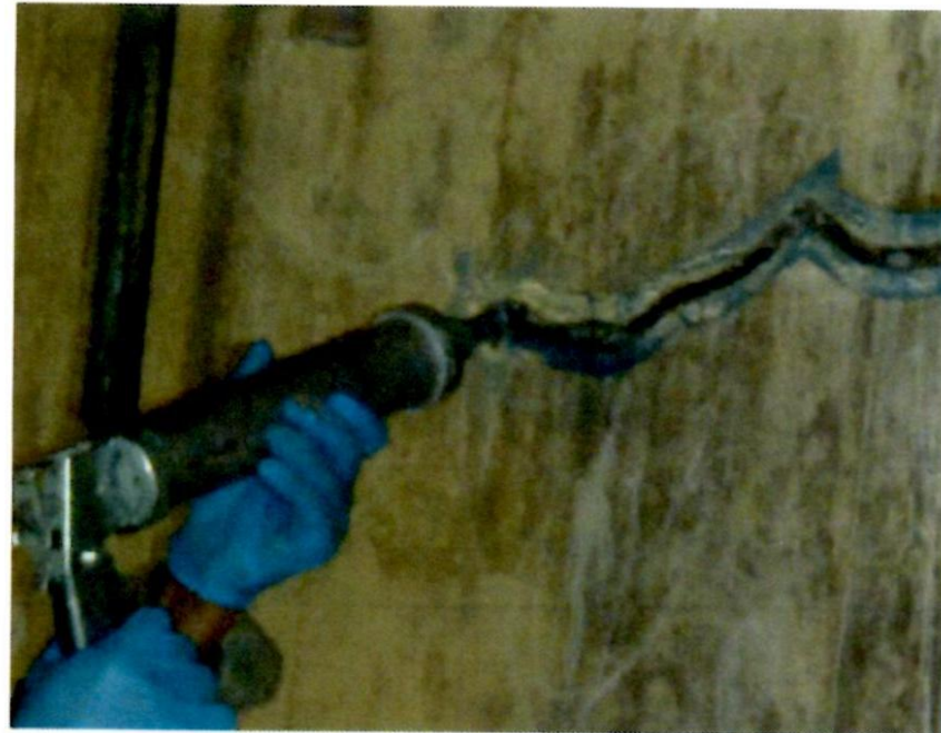
解説 写真-2.3.2 ひび割れ充填工法の施工例
