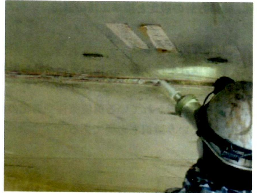
解説 写真-2.3.2 ひび割れ充填工法の施工例
