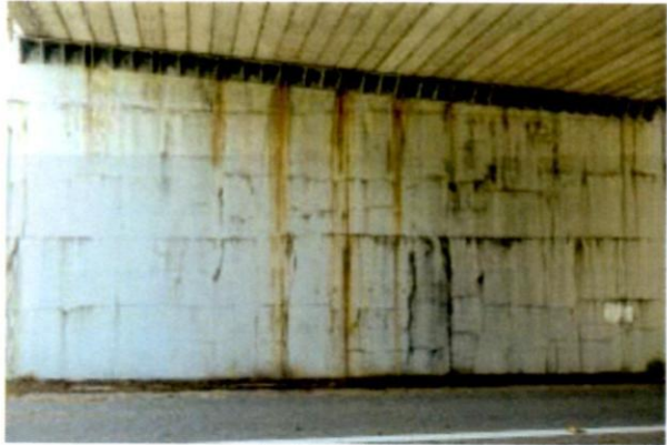
a) 橋台全体
