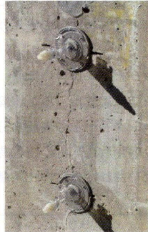
解説 図-3.3.5 クロスカットを再利用した注入器の設置例
