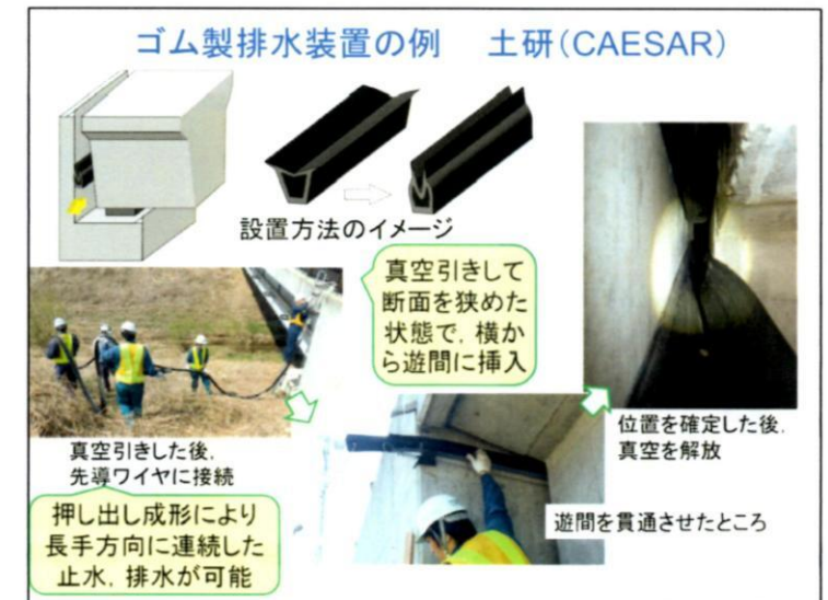
解説 図-2.3.3 橋梁の桁端における樋の設置 (資料提供: 土木研究所 CAESAR)
