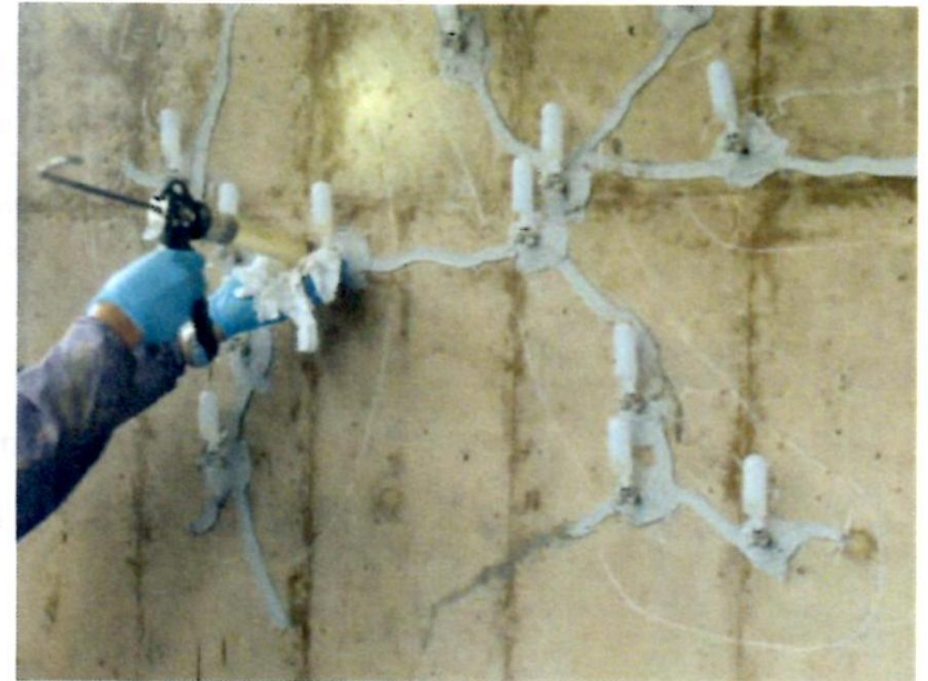
解説 写真-2.3.1 ひび割れ注入工法の施工例
