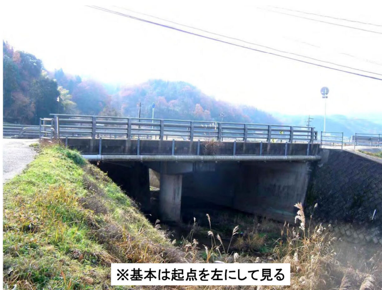
STEP1 橋梁側面からの変状確認
