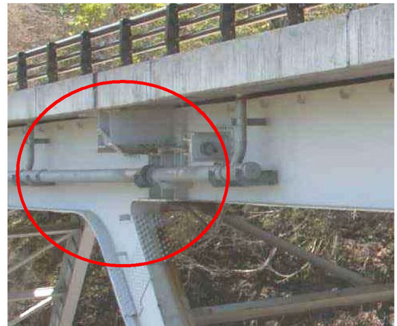
(ラーメン橋隅角部)
