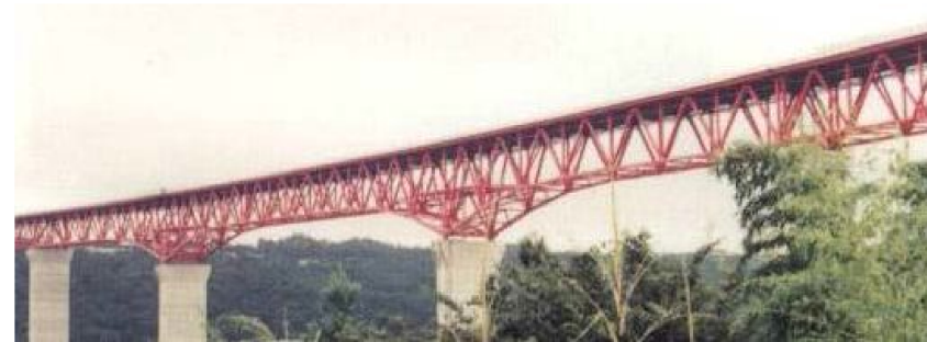
(c) トラス橋
