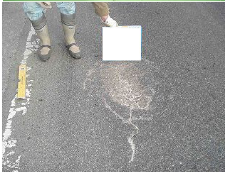
床版下面にひび割れ、遊離石灰の損傷 直上の舗装面のひび割れ（石灰分を含む）
