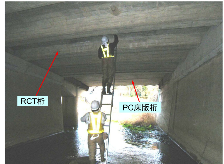
STEP2 桁下の変状確認
