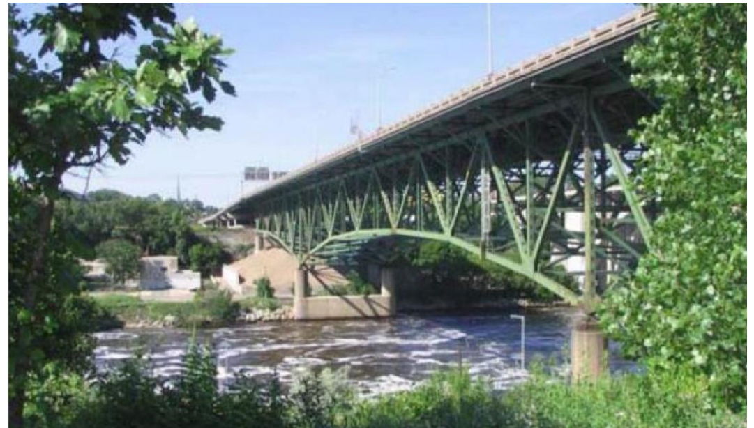
(主構造がトラス構造)
