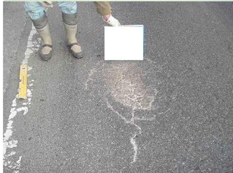
床版下面にひび割れ、遊離石灰の損傷 直上の舗装面のひび割れ（石灰分を含む）
