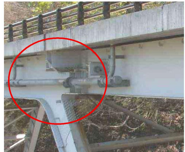
(ラーメン橋隅角部)
