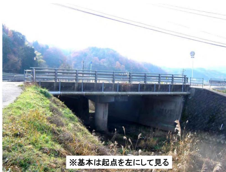
STEP1 橋梁側面からの変状確認
