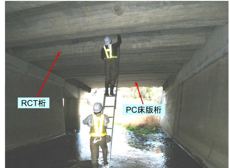
STEP2 桁下の変状確認
