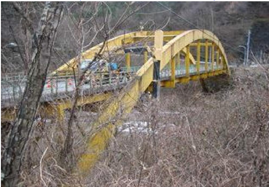
(中路式アーチ橋)
