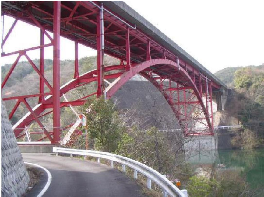
(上路式アーチ橋)
