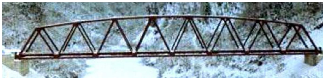
(b) トラス橋(写真)
