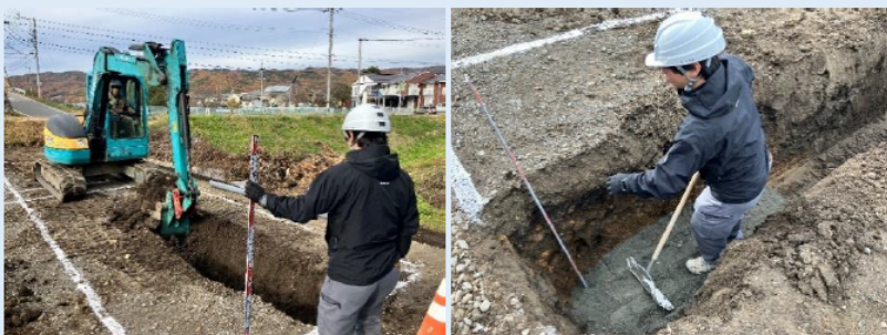
重機オペレーターと深さ計測・基礎砂敷き均し作業をする手元作業員の2人で施工
