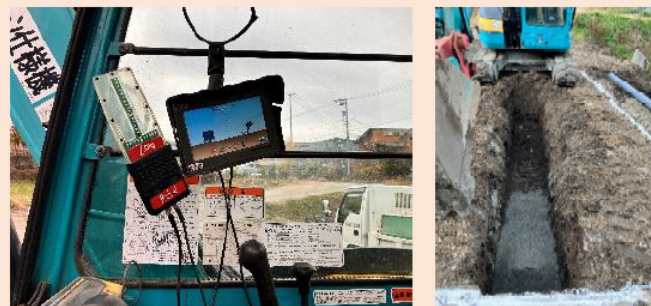
ガイダンスシステムで重機オペレーター1人で掘削・基礎砂施工
