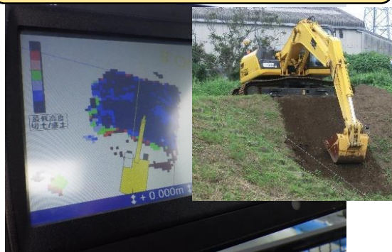
ICT建機の施工履歴データ
