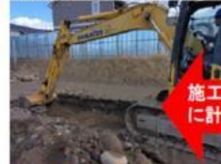
②3D-MG施工 + ②刃先による計測
