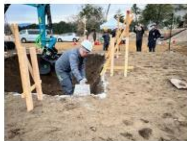
手元作業員が多い現場
