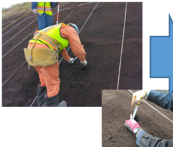
人力による出来形計測状況
