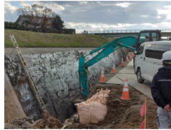
掘削法面整形
