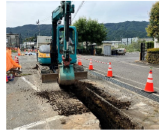
床堀(管路敷設)
