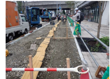
床堀(点字ブロック敷設)
