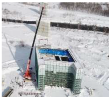
プレキャスト部材の活用
