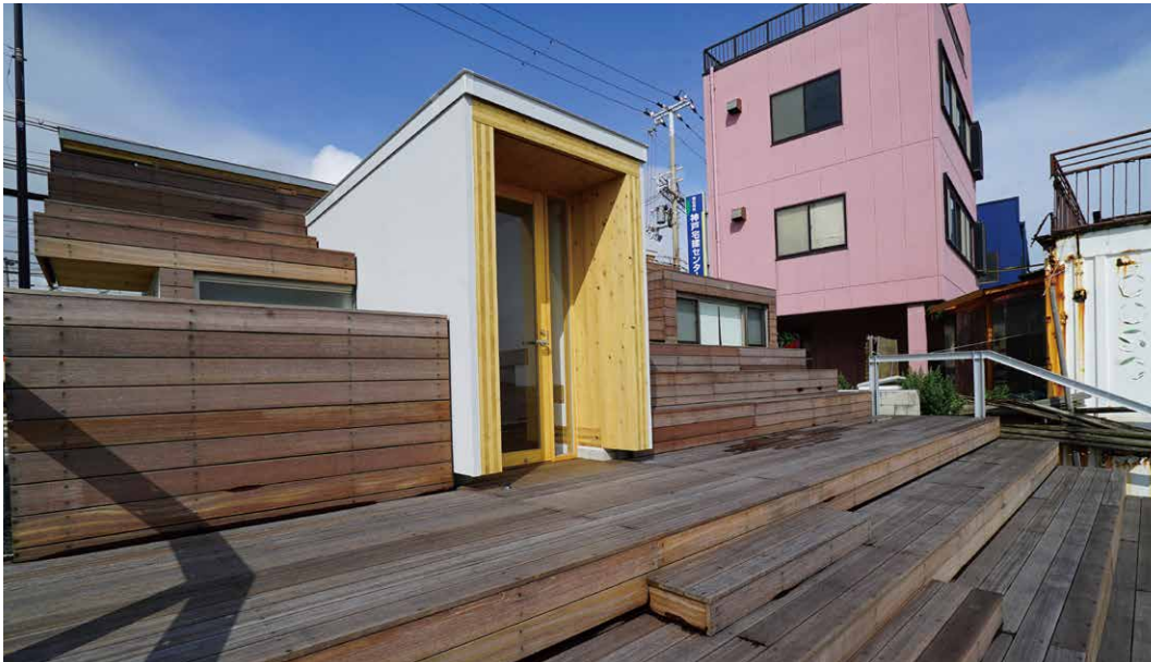
CLTの屋根の上に防水をしてデッキを敷いたテラス席
