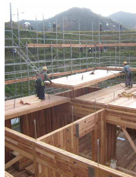
大判床パネルの敷き込み
