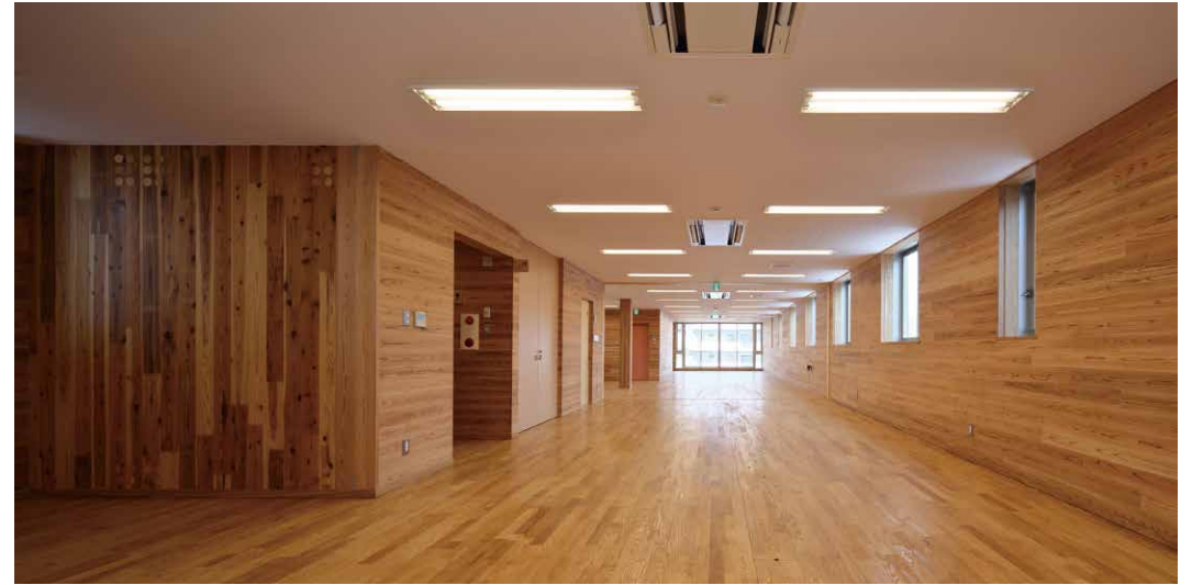
耐震要素のCLT(左側の縦張り壁)を現しにした会議スペース
