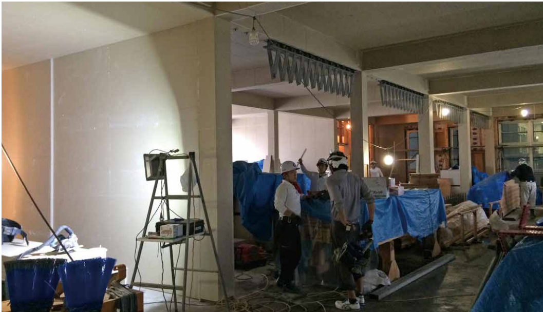
耐火建築物のためCLT耐震壁を強化せっこうボードで被覆する
