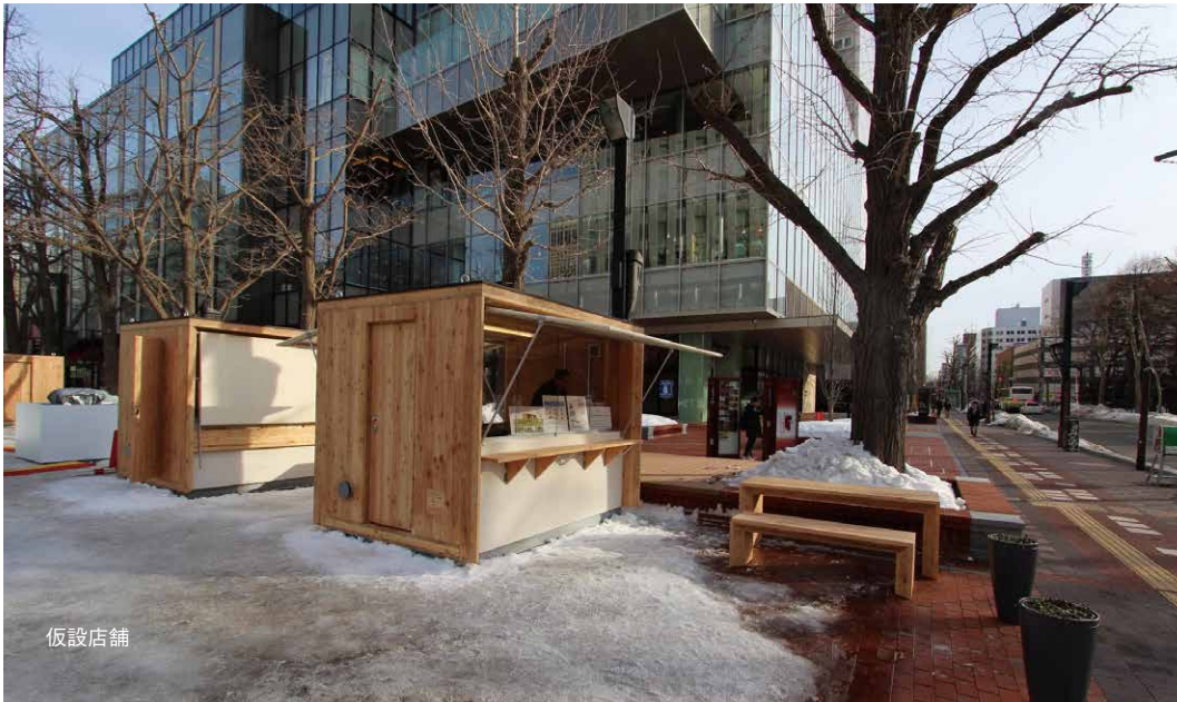
札幌駅前通まちづくり(株)CLT 仮設店舗
