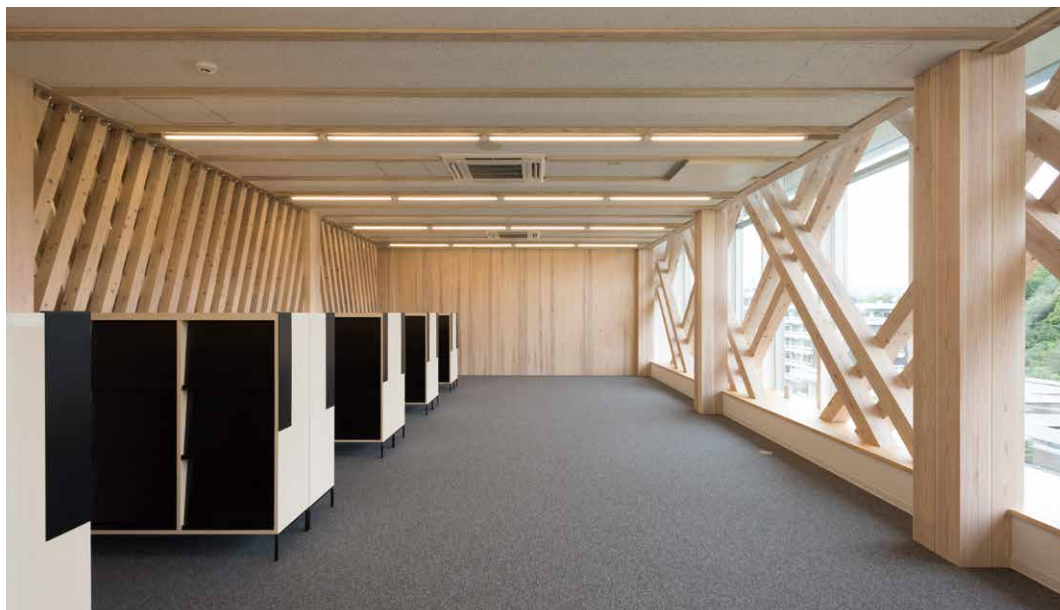
無節のスギラミナを使ったCLTによる間仕切壁
