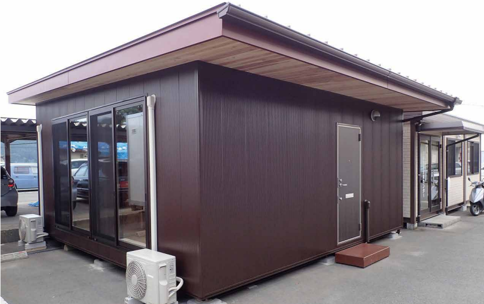
熊本県西原村仮設宿泊施設
