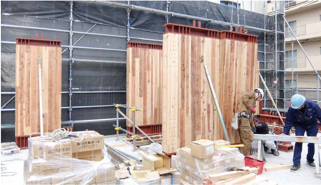
CLT壁の施工中の様子
