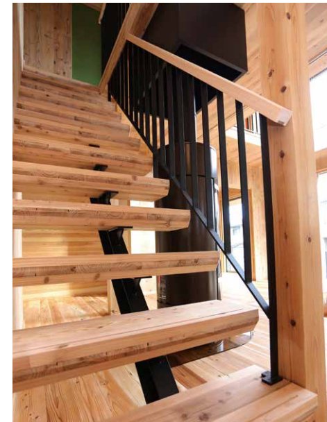
階段段板へのCLTの活用
