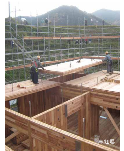
CLTパネル工法による3階建て寮の建て方
