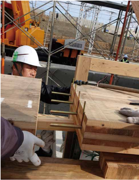
CLT 同士の現場接着接合
