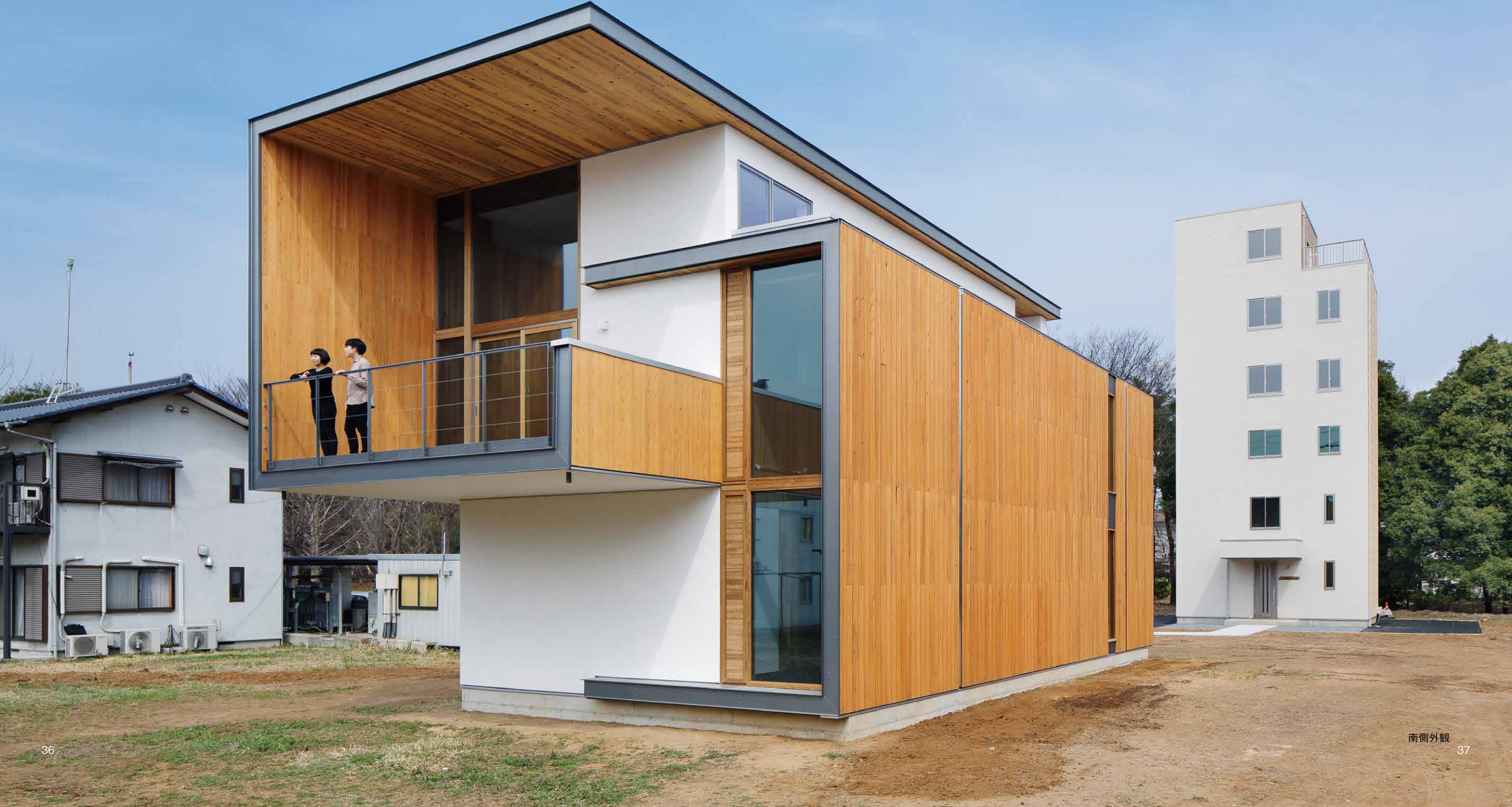
CoCo CLT(つくばCLT実験棟)
