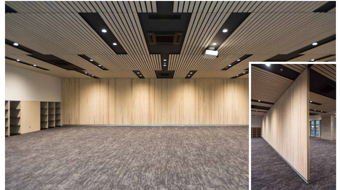
無節のスギラミナを使ったCLTによる可動間仕切壁
