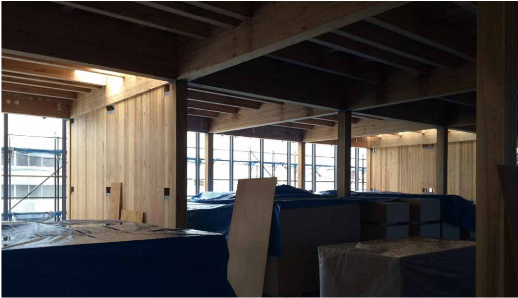
CLTを軸組工法の耐震壁として使用
