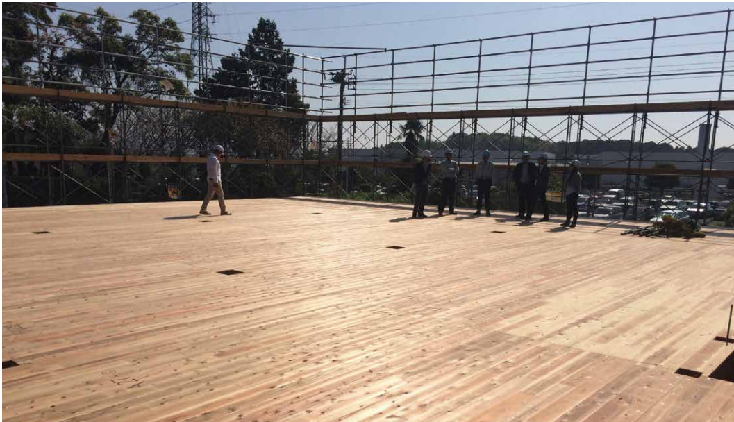
軸組のはりの上にCLTを床面材として使用
