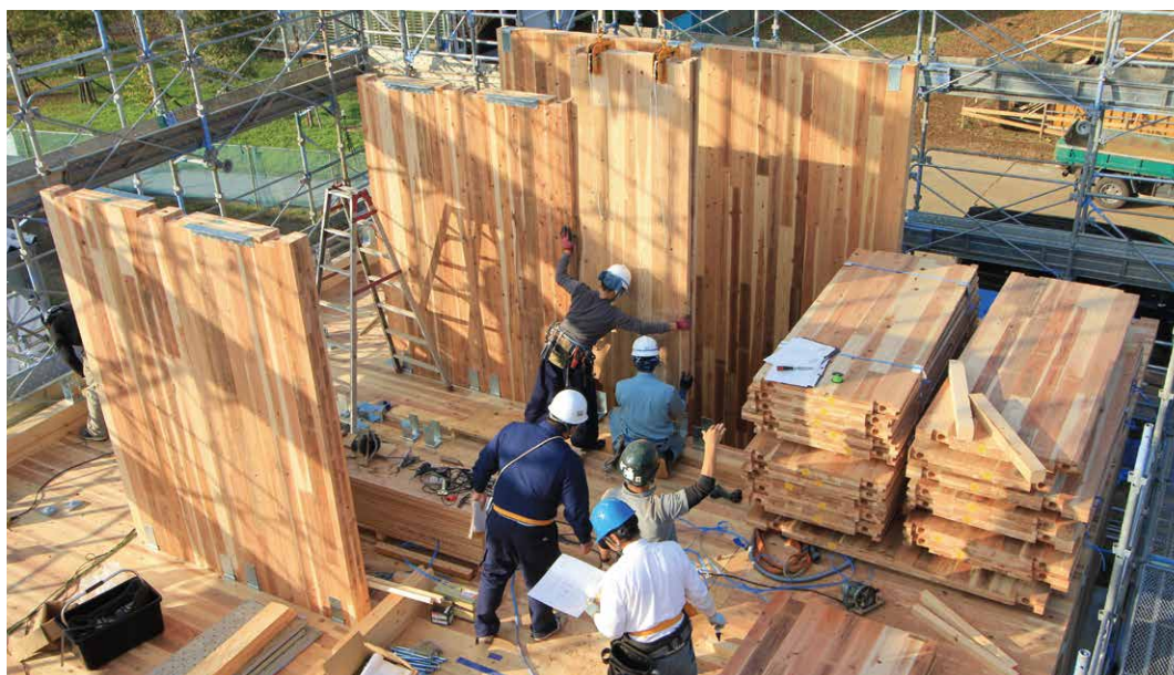
壁パネルの建て方
