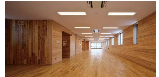
CLTに耐火被覆した上に木材仕上げをした事例
