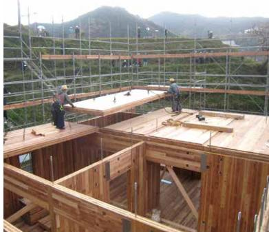
壁・床・屋根をCLTで構成する工法で、2016年4月の国土交通省告示に沿って設計します。床のスパンが大きい場合などは、必要に応じて柱やはりを設けることも可能です。3階建て以下の準耐火建築物で設計する場合には、準耐火構造の燃えしろ設計を用いれば、壁・床・屋根のCLTだけで防耐火性能を確保することができ、必要に応じて、CLTの表面に断熱材や仕上げ材を付加することができます。
