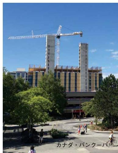
床にCLTを使った18階建て学生寮の建て方
