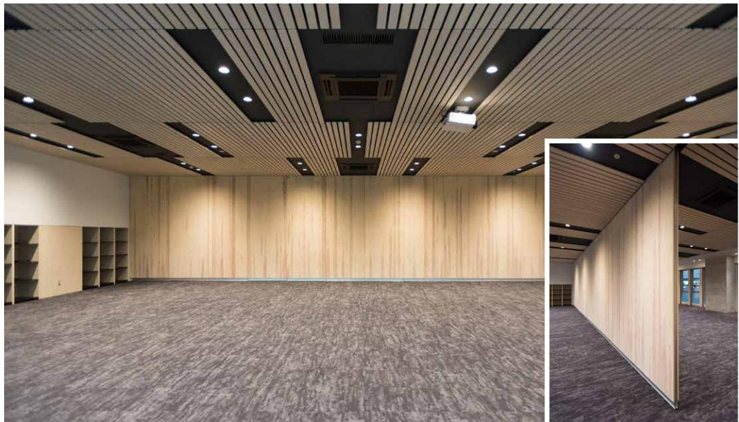
無節のスギラミナを使ったCLTによる可動間仕切壁
