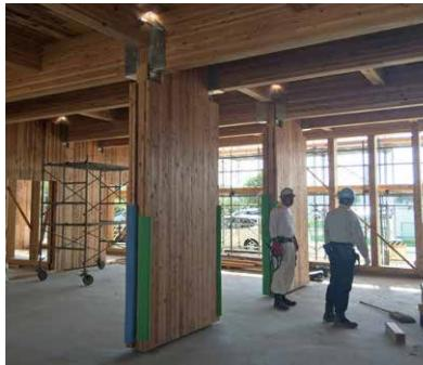
従来の柱とはりを用いた軸組工法の躯体に対して、構造用合板等と同様に壁の耐震要素や、床の水平剛床等としてCLTを用いる工法です。そのため、住宅等の軸組工法の延長上で設計・施工ができ、比較的容易にCLTを用いることが可能となります。使用するCLTの種類・寸法によっては、耐震要素としての性能を確認するための実験等が必要になることもあります。
