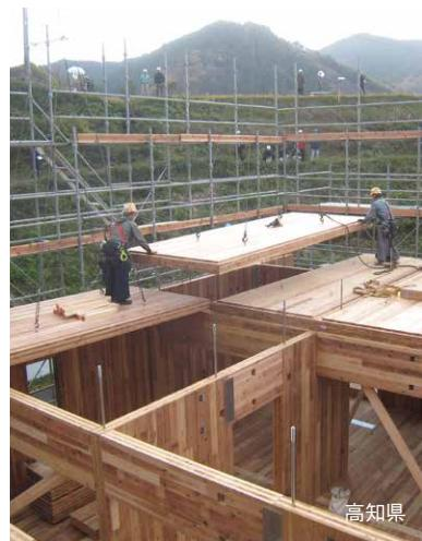
CLTパネル工法による3階建て寮の建て方
