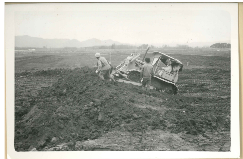
ブルドーザーによる整地作業
