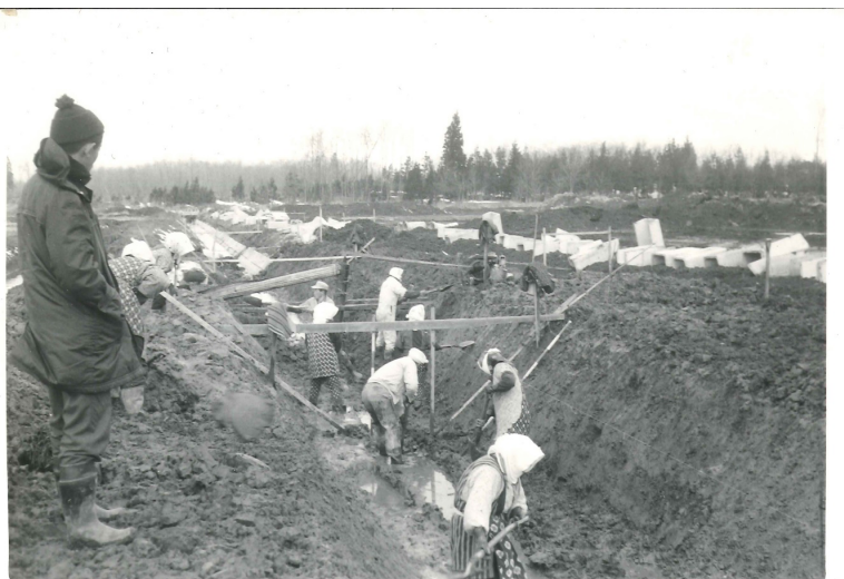
幹線排水路工事
