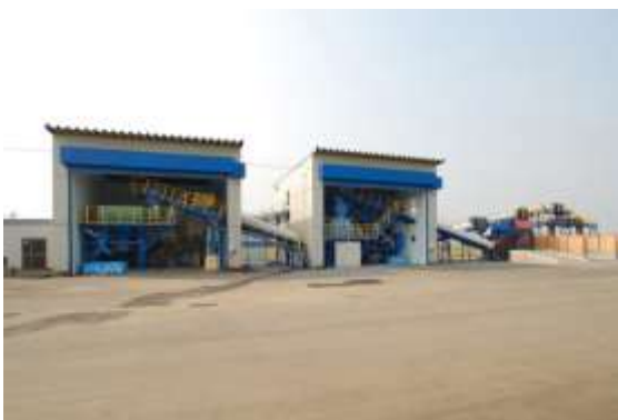
破碎造粒プラント
