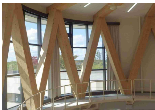
〔耐火部材を使用した福祉施設〕
