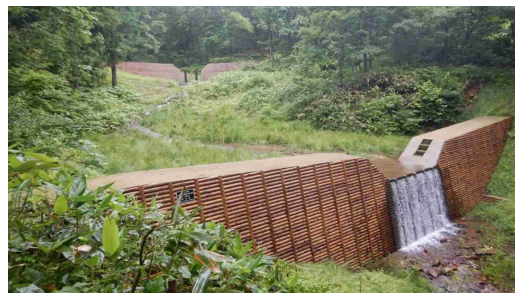
〔公共土木での木材利用〕
