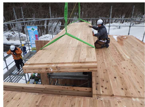
〔施行中のCLTパネル〕
