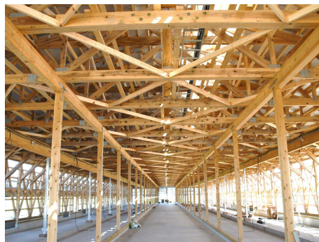
〔一般流通材を活用した畜舎〕
