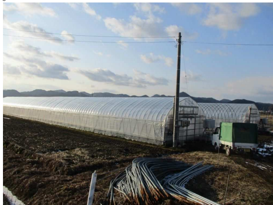
【ハウス団地建設中 現在2棟が稼働中】
