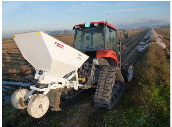
【モミガラ補助暗渠の施工】
