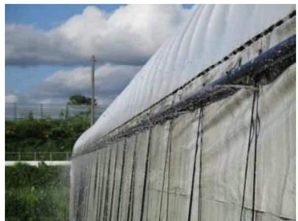
【消雪のための散水設備】
