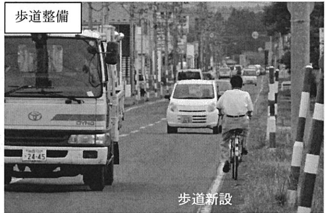
国道108号 薬師堂工区 (由利本荘市)
