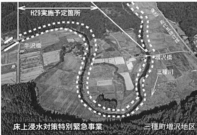
三種川（三種町） 河道掘削・護岸工
