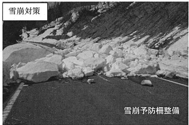
国道398号 小安奥山工区 (湯沢市)
