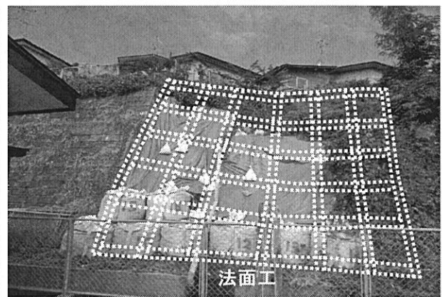
県単砂防事業 扇田道下地区（大館市） 急傾斜地法面工
