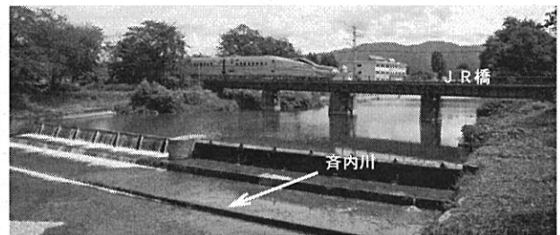
斉内川（大仙市） JR橋架替工事
