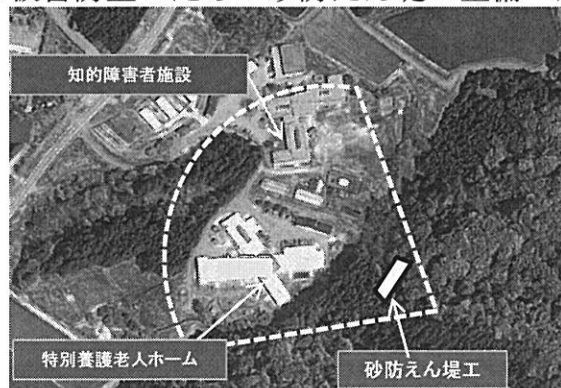
八九郎東沢 （小坂町） 砂防えん堤工
