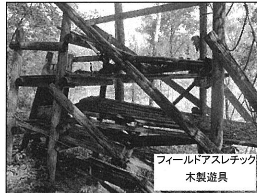
フィールドアスレチック遊具更新 [中央公園]
