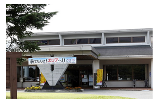
〈南部老人福祉総合エリア〉 昭和63年建築、RC造2階建
