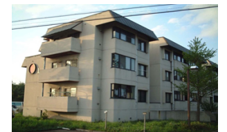
〈県営獅子ヶ森住宅〉 昭和58年建築、RC造3階建
