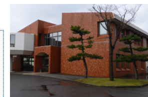
〈産業技術センター本館〉 昭和57年建築、RC造2階建
