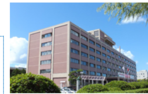
〈秋田県庁舎〉 昭和34年建築、RC造6階建
