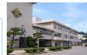
〈能代工業高等学校 校舎〉 昭和43年建築、RC造4階建
