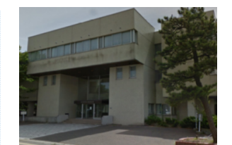
〈旧議員会館〉 昭和55年建築、RC造3階建
