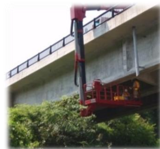
橋梁点検作業
