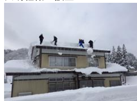
共助組織による雪下ろし作業
