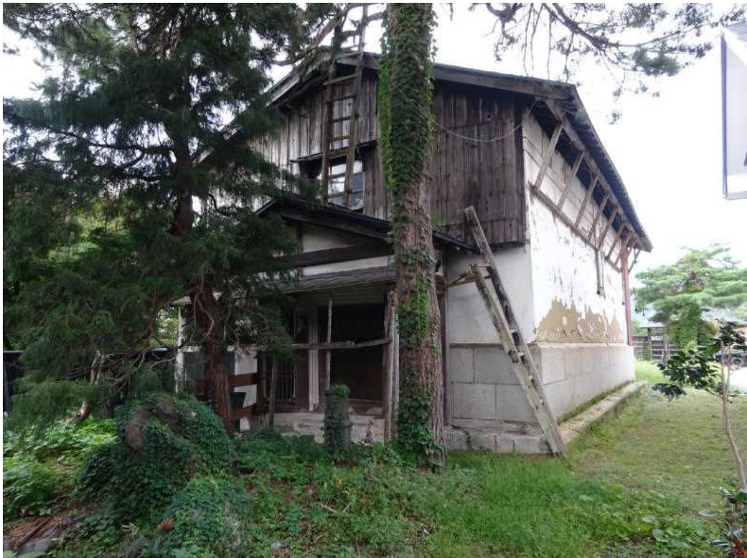
旧松浦家住宅（米蔵外観）
