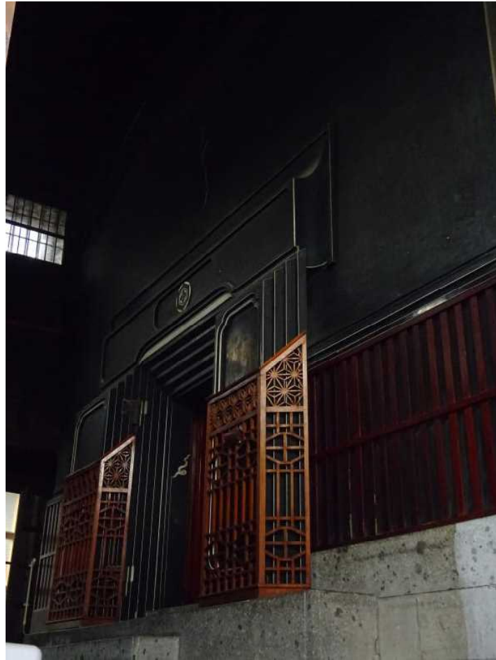
旧松浦家住宅（座敷蔵外観）
