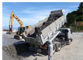
現場荷降ろし
