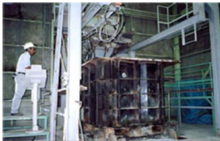
石炭灰、セメント、水の混練物を型枠に投入
