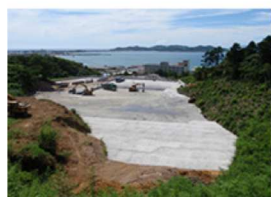
宅地造成盛土への適用事例
