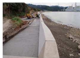
護岸ブロック背面裏込め
